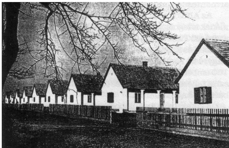
Az 1940–1941. évi árvízkarosultak számára épített új házsor Páhiban
