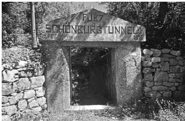
Monte San Michele, Schönburg alagút bejárata. (A hegygerinc alatt fűrt alagút bejárata)
