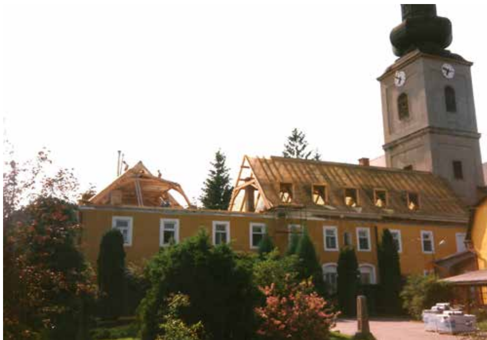
Második ütem: tetőtér felújítása és beépítése 1998/99-ben
