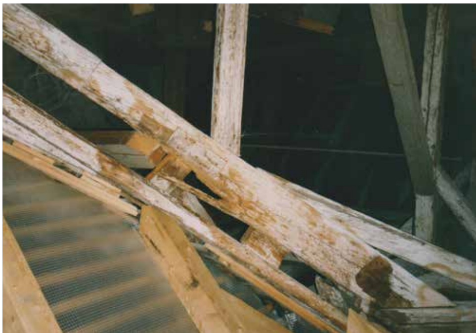
027 Életveszélyes a tetőszerkezet
