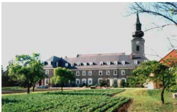
Az elkészült tetőszerkezet teljes felújítása és beépítése 2000 októberében
