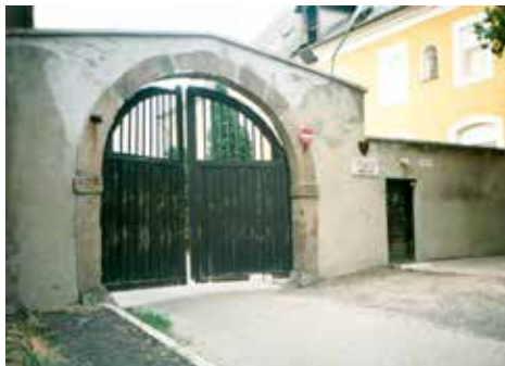
A renház bejárati főkapuja a felújítás előtt
